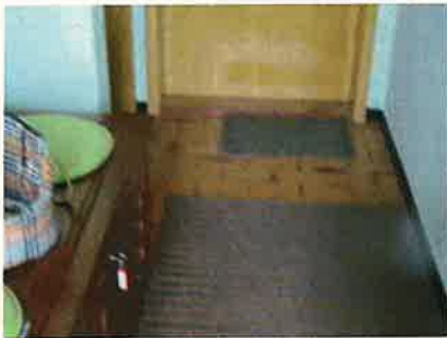
Entrée immeuble Rez
