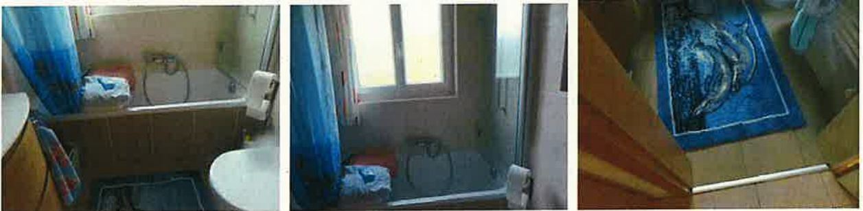
salle de bain appt. 1 er étage (entièrement rénovée après 2010)
