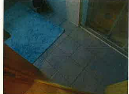
sol douche combles
