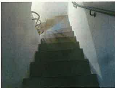
Escalier sous-sol rez
