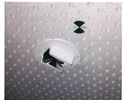
Marquage de l'éclairage
