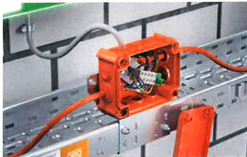
Exemple de boîte de dérivation avec maintien de fonction (OBO Bettermann AG)
