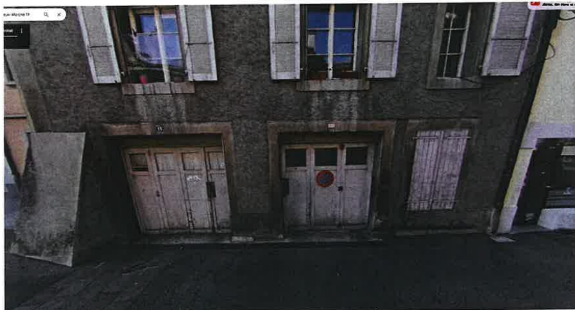
FACADE SUD AVANT TRAVAUX
